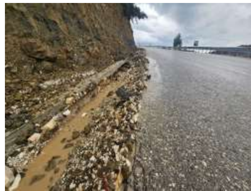
Figura 5. Bllokim kanali dalje e ujrave në trupin e rruges
