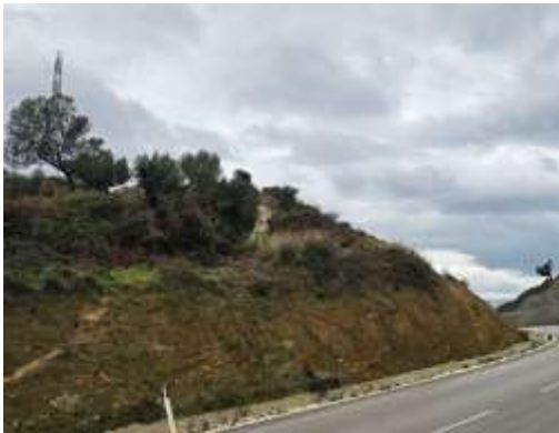
Figura 4 Shembja e kanaleve të ujrave të sipërm
