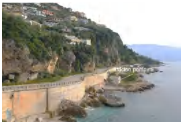
Fig. 4 Stacioni i pompimit i burimit karstik Uji i Ftohtë – Vlorë. Zona e re urbane, pa infrastrukturë për grumbullimin dhe përpunimin e ujërave të zeza, zhvillohet mbi tunelet ujëgrumbulluese që ndodhen në brendësi të formacioneve ujëmbajtëse gëlqerore.
